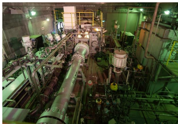
図3 ラムジェットエンジン試験設備 (RJTF)
