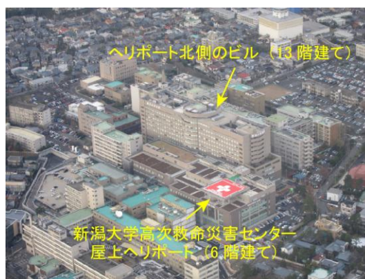
図3 屋上ヘリポートの周辺状況
